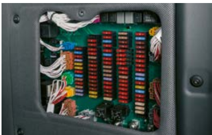
Basiszentralelektrik im geschützten Fach.
