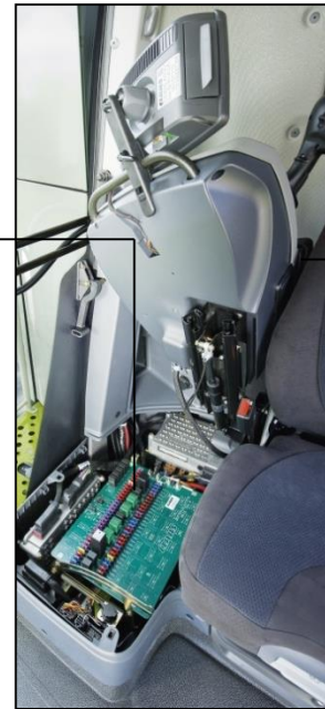
Die BASIS Zentralelektrik befindet sich in der Kabine unterhalb der Bedienkonsole. Hier befinden sich Relais und Sicherungen für die Maschinenfunktionen.
