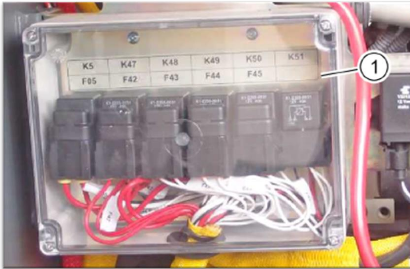
Sicherungen im Motorraum
