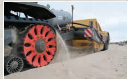
Mit dem Schürfkübel werden größere Sandmengen verlagert.
