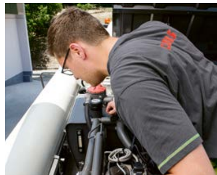
Enkel visuell kontroll av alle oljenivå.
